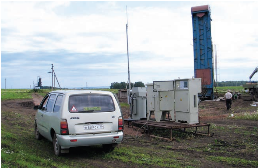
Рис. 3. Монтаж и наладка наземного оборудования УЭЦН на скважине № 28543 НГДУ «Азнакаевскнефть»
