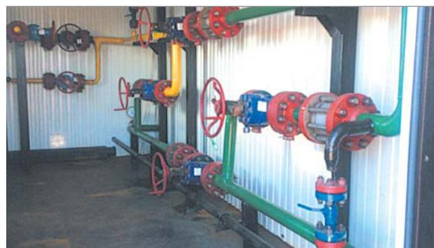
**Рис. 2.** Наземное оборудование для реализации ВГВ на Мензелинском месторождении
